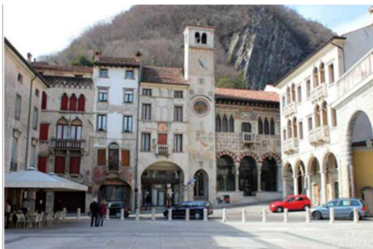
Recupero energetico e architettonico del Centro storico di Serravalle
